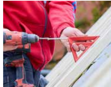
Die Einschraubhilfe: zweckmäßiges Werkzeug zum exakten Ansetzen der Meisterdach Schrauben unter 60° sowie zum mittigen Einschrauben in Konterlatte und Sparren.
