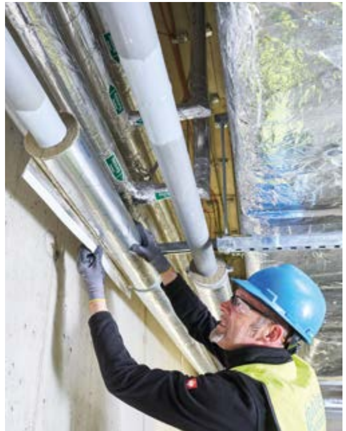
Montage der ROCKWOOL 800 an Heizungs- und Trinkwasserleitungen
