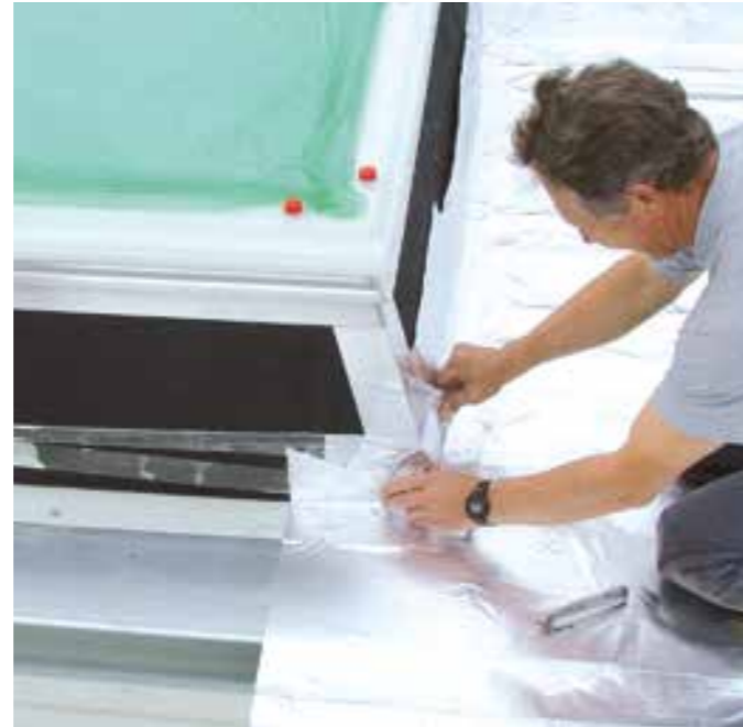
Detailausführung Lichtkuppelanschluss
