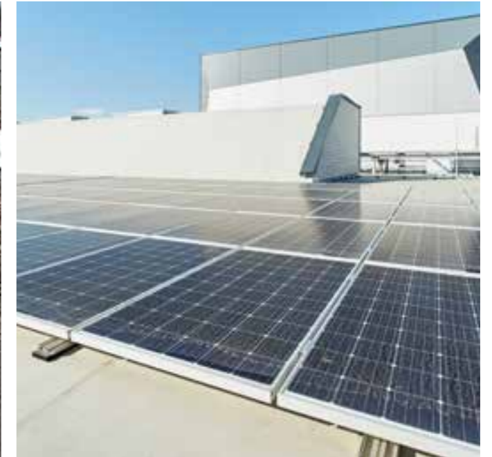
Neue Beanspruchung durch Photovoltaikanlagen
