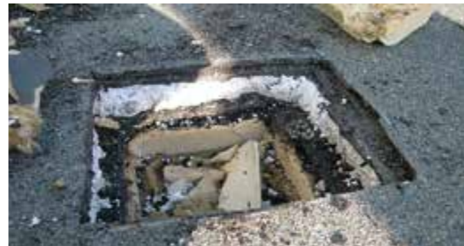
Eine Dachöffnung bringt Gewissheit
