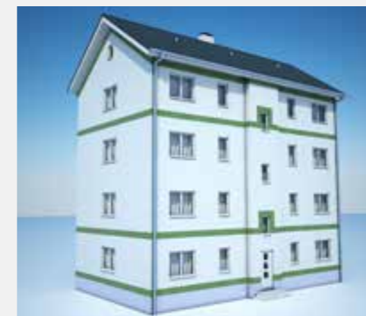
Behinderung der Brandausbreitung durch Brandriegel.
