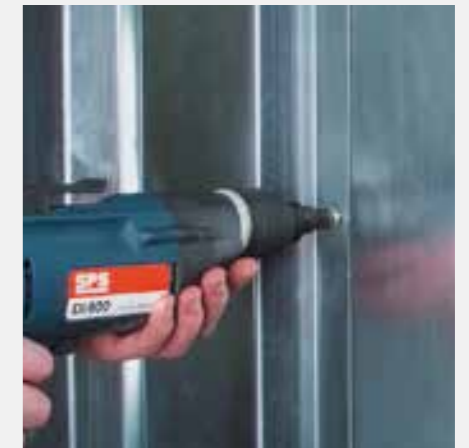
Der Steelrock Plus Distanzbefestiger wird ohne Tiefenanschlag und Drehmomentbegrenzung gesetzt.
