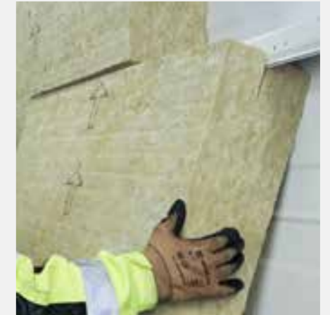
Steelrock Plus wird mit dem Einschnitt zum Obergurt in die Kassetten eingebaut.
