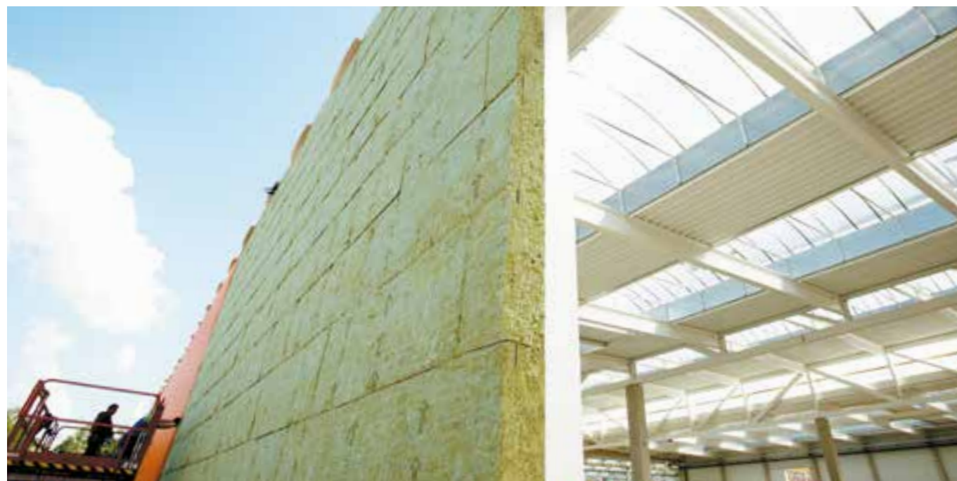
Durch die Dämmstoff-Überdeckung der Metallstege in 40 mm oder 80 mm Dicke sorgt das Steelrock Plus Dämmsystem für eine zuverlässige Reduzierung von Wärmebrücken.
