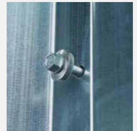
Nur die Außenschale bzw. das Hutprofil wird mit 6,5 mm vorgebohrt.
